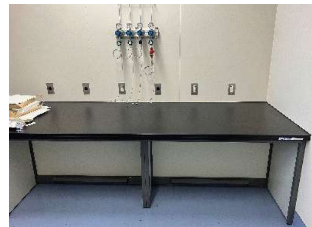
筐体撤去完了
